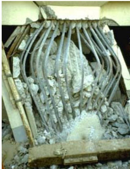
Abb. 6: Einsturz von Stahlbetonbrückenstützen beim Erdbeben von Kobe, Japan 1995
