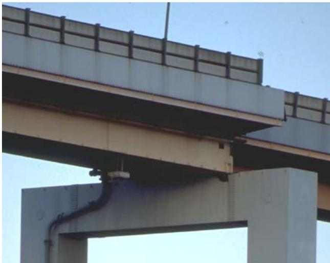
Abb. 5: Brückenträger von den Lagern auf das Stützenjoch gefallen. Erdbeben von Kobe, Japan 1995
