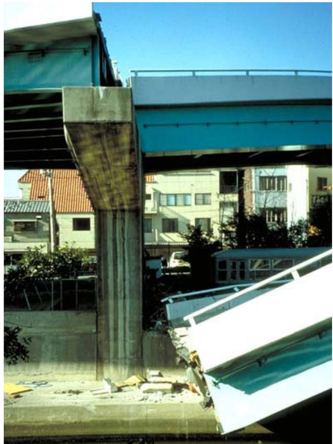
Abb. 4: Absturz eines Brückenträgers beim Erdbeben von Kobe, Japan 1995
