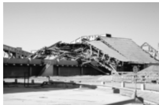
Bild 5: Abgestürzte Stahlbetonfachwerkbinder einer Lagerhalle von IFFCO
