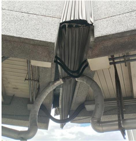
Illustration 5.5-6. Raccordement en forme  $\Omega$  des tuyauteries au niveau du joint sismique
