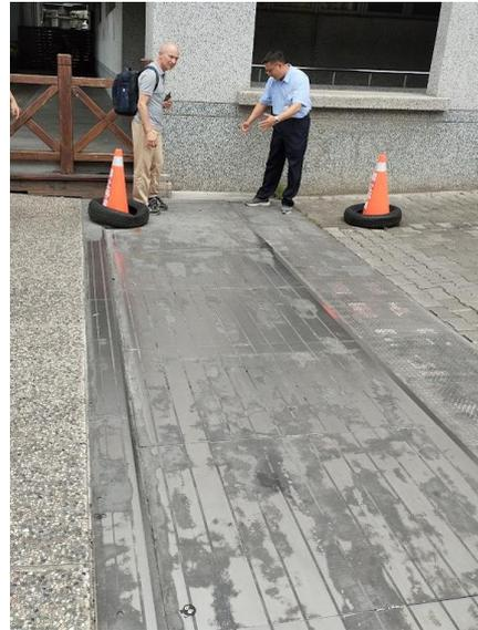
Illustration 10.1-2. Couvre-joint sismique entre bâtiments à l'Hôpital Hualien réparé pour le passage des services de secours
