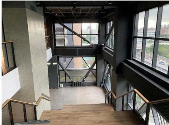
Illustration 10.1-9. Amortisseurs diagonaux à friction du bâtiment du NCRE
