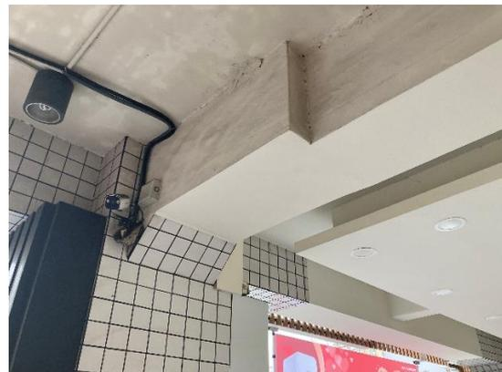
Illustration 10.1-4. Détail du chemisage, le changement de section de la poutre est visible.
