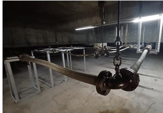
Illustration 5.5-7. Tuyauteries maintenues par des flexibles suspendus
