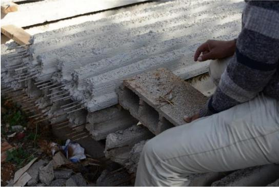
Figure 4-5 : Dépôt de poutrelles en béton armé pour dalles à hourdi, près d'Amizmiz (crédit Y. Zhu).
