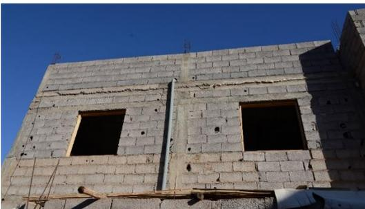
Figure 4-7 : Construction en béton et maçonnerie à Toufssirine (crédit Y. Zhu).
