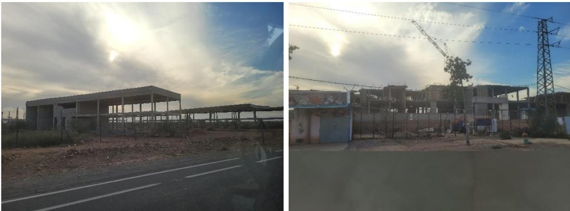
*Figure 4-1 : Gauche : bâtiments en béton armé en cours de construction de type cadre ; droite : bâtiments en béton armé en cours de construction de type cadre avec voiles en béton armé ; (crédit E. Lattion, proche de Marrakech).*
