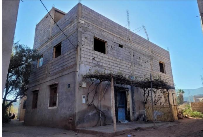
Figure 4-2 : Bâtiment d'habitation en béton typique des zones rurales, avec piliers et sommiers en béton armé, remplissages en maçonnerie et agrandi sur plusieurs années, voire générations. A Toufssirine. (crédit E. Lattion).
