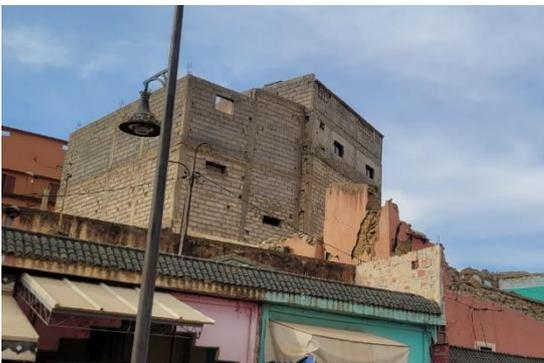
Figure 4-11 : Bâtiment hybride béton-maçonnerie à Amizmiz (crédit E. Lattion).
