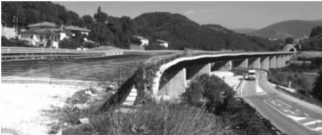
Bild 9: Strassenbrücke Traone von der Widerlagerseite Foligno aus gesehen.
