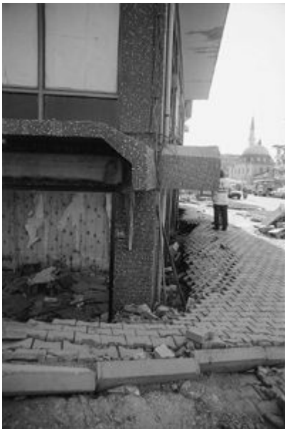
Bild 10. Adapazari: Einsinken eines Gebäudes und Aufwölben infolge Materialumlagerungen
