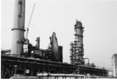
Bild 13. Die Querrahmen der vorfabrizierten Konstruktion scheinen weitgehend intakt. Sämtliche Rahmenstiele sind jedoch im untersten Drittel durch einen Schub-/Biegebruch irreparabel beschädigt
