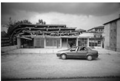
Bild 5. Komplettes Versagen eines Gebäudes ("Pancake"-Schaden)
