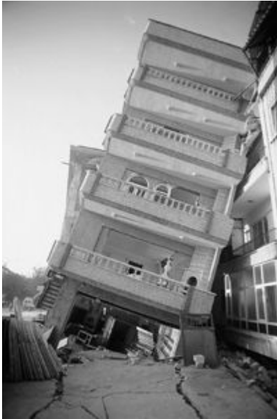
Bild 10. Adapazari: Einsinken eines Gebäudes und Aufwölben infolge Materialumlagerungen
