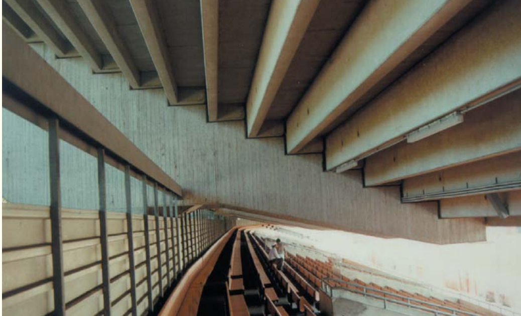
Bild 7: Untersicht der Tribünenstufen und Kragarm des Tribünenbinders
