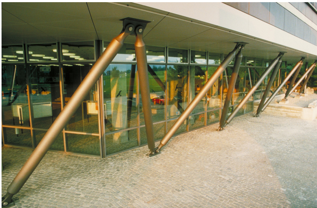
Bild 2: Nachträglich montiertes Stahlfachwerk zur Erhöhung der Erdbebensicherheit eines Hörsaalgebäudes der ETH Zürich
