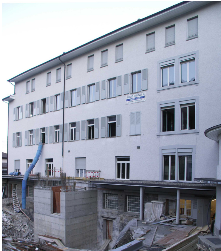
Bild 1: Zur Erhöhung der Erdbebensicherheit erhält dieses Schulhaus in Monthey VS seitlich einen neuen Liftkern aus Stahlbeton.
